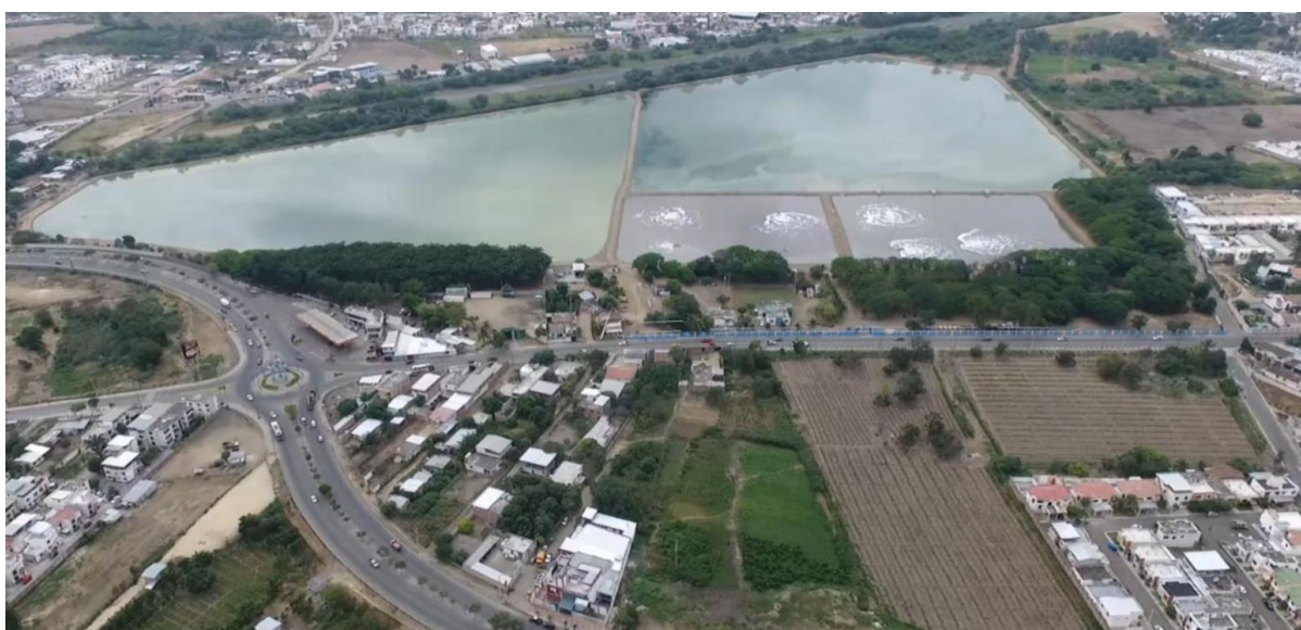
Figura 6. Vista aérea de la PTAR Portoviejo
