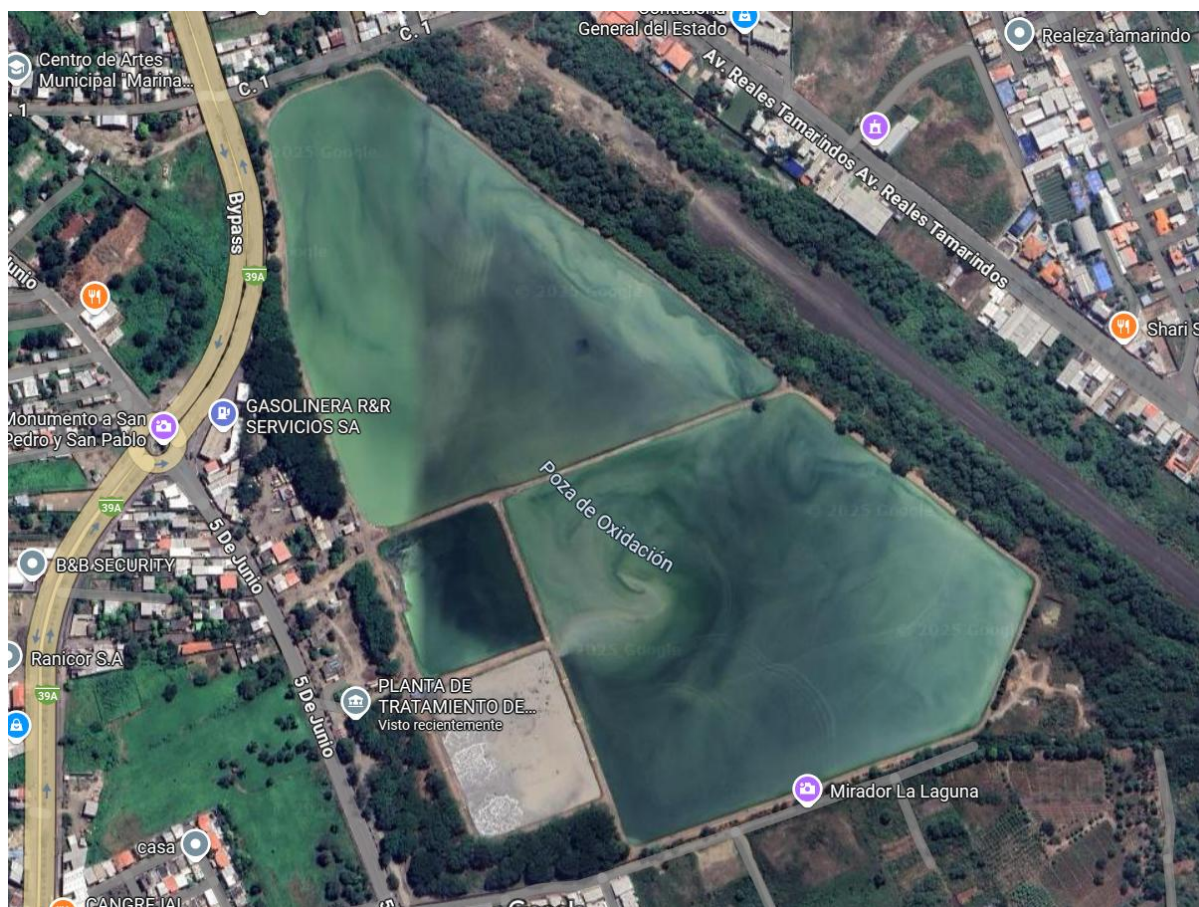
Figura 5. Vista aérea de la PTAR Portoviejo
